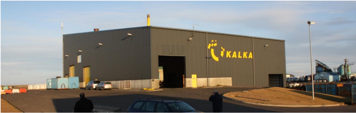
KALKA Sorpbrennslustöð, þar er meðal annars brenndur áhættuvefur.
